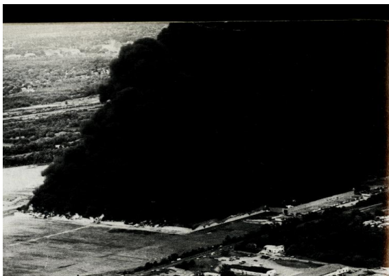
Incendio en K-Mart Falls Township, USA 1982. US$ 113 millones de pérdidas, destruidos 119.000 m 2
