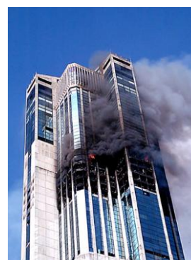
Incendio en Torre Este de Parque Central. Caracas, 17 de octubre de 2004
