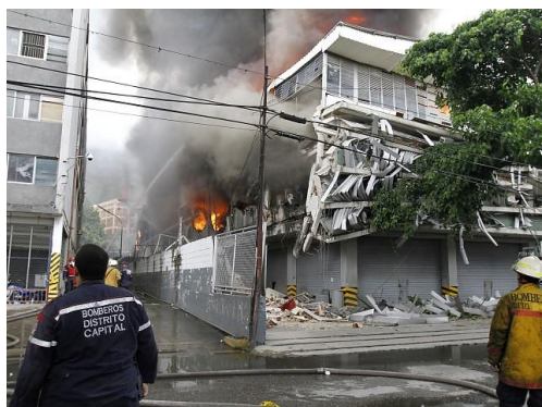
Incendio en depósitos de Revlon, Caracas 5 de Junio de 2011. Edificio de cinco pisos colapsaron los tres pisos superiores
